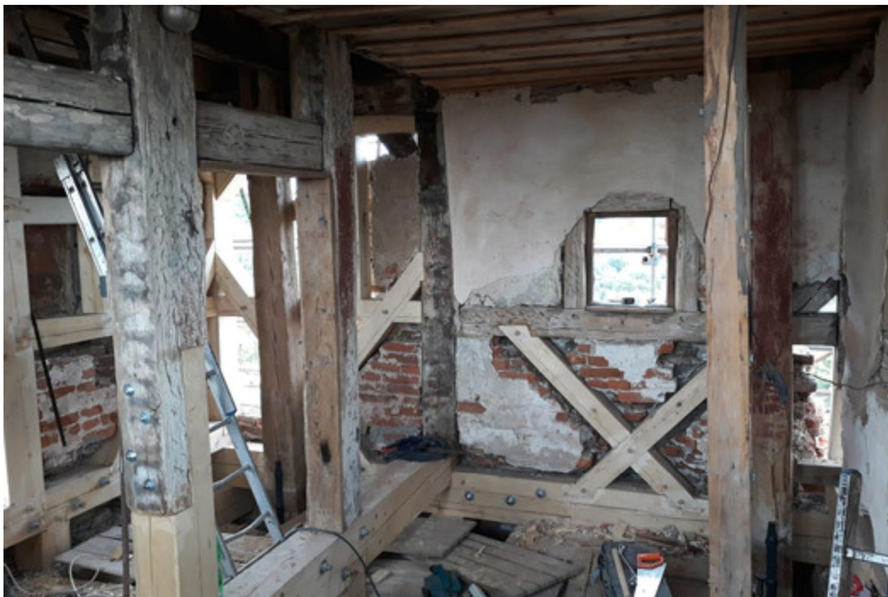
Probíhající obnova hrázděné konstrukce
